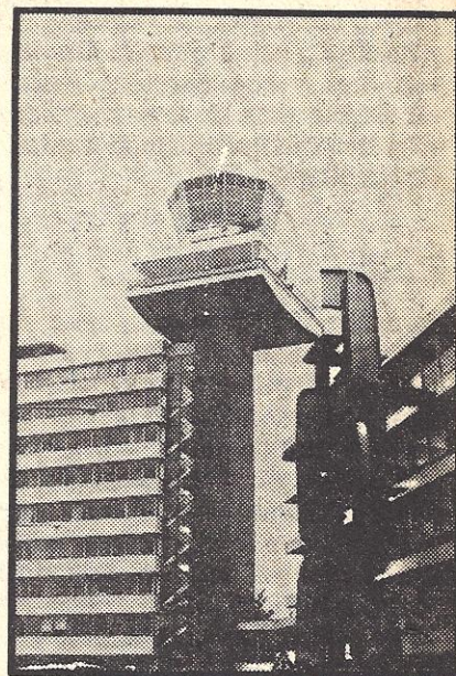
De luchtverkeersstoren van Schiphol. Boven op staat onder een koepel de „slecht-weer” radar.
